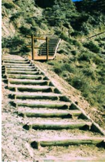
Tramo de sendero acondicionado con peldaños de escalera. Foto: Archivo Prames
